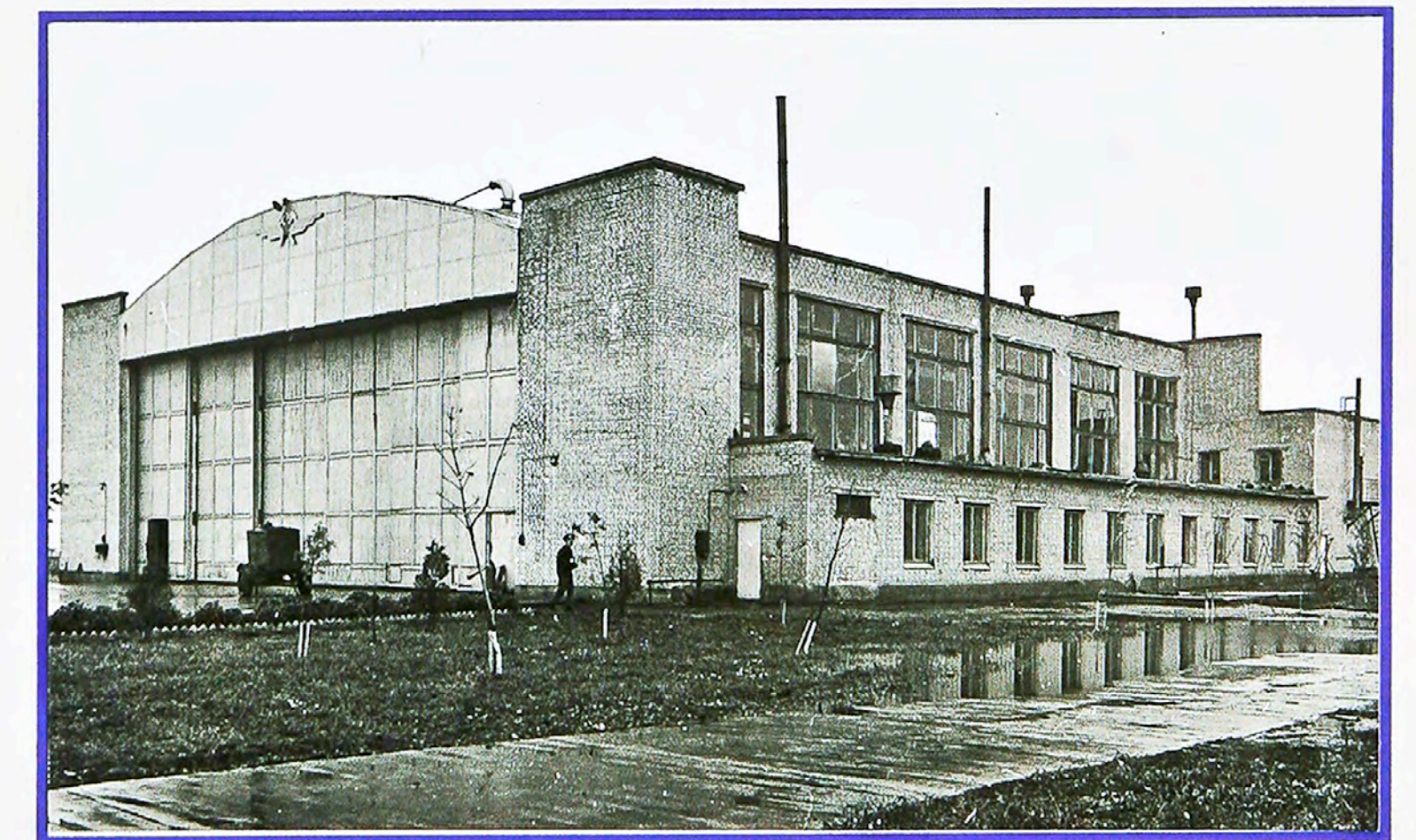
Корпус ремонту вертольотів у м. Конотоп
