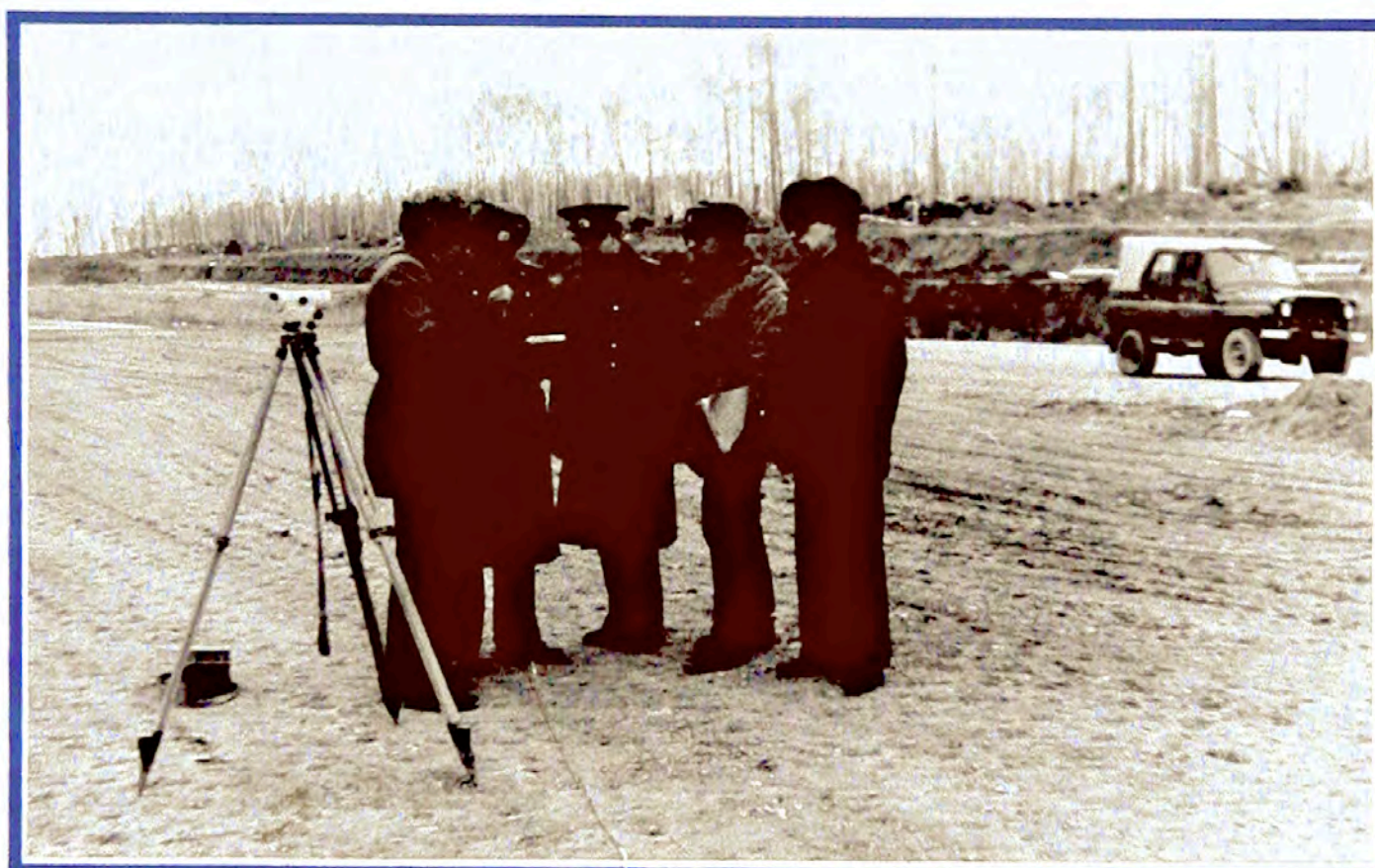
1979 р. Проведення авторського нагляду за будівництвом аеродрому Менгон.
